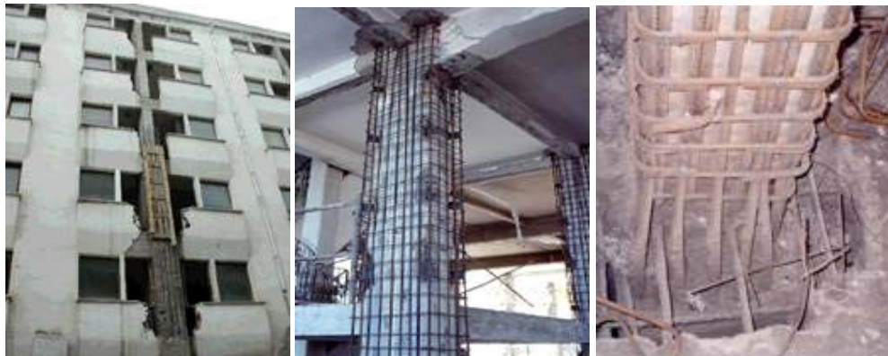
Σχήμα 1.1.1: Εφαρμογή μανδυών Ο/Σ ως καθολική μέθοδος ενίσχυσης (Θερμού, 2007).
