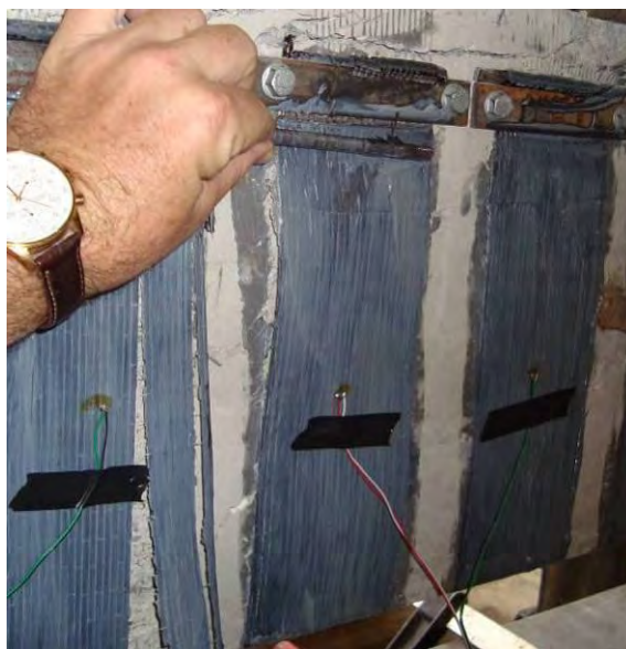
Σχήμα 4.26 Μορφή αστοχίας δοκιμίου RB150Ca
