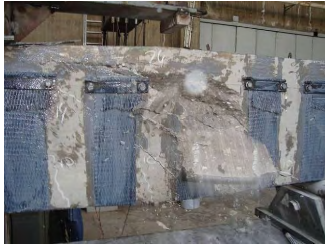
Σχήμα 4.19 Μορφή αστοχίας δοκιμίου RB200S
