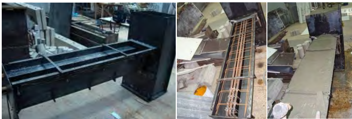
Σχήμα 3.22 Κατασκευή δοκών Ο/Σ διατομής πλακοδοκού 120/360/360(mm)
