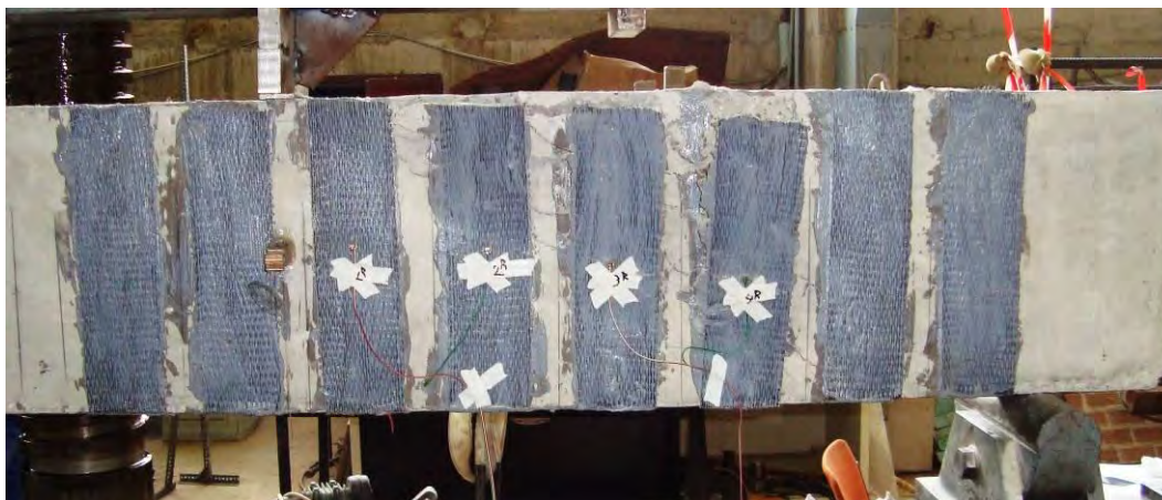
Σχήμα 4.29 Μορφή αστοχίας δοκιμίου RB150S
