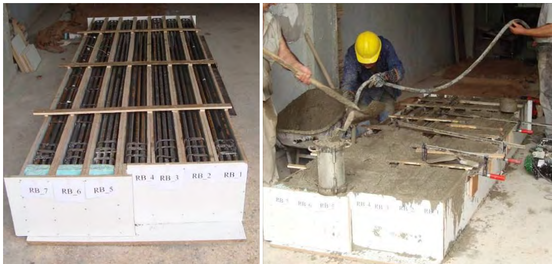
Σχήμα 3.13 Κατασκευή ορθογωνικών δοκών 120/360(mm)
