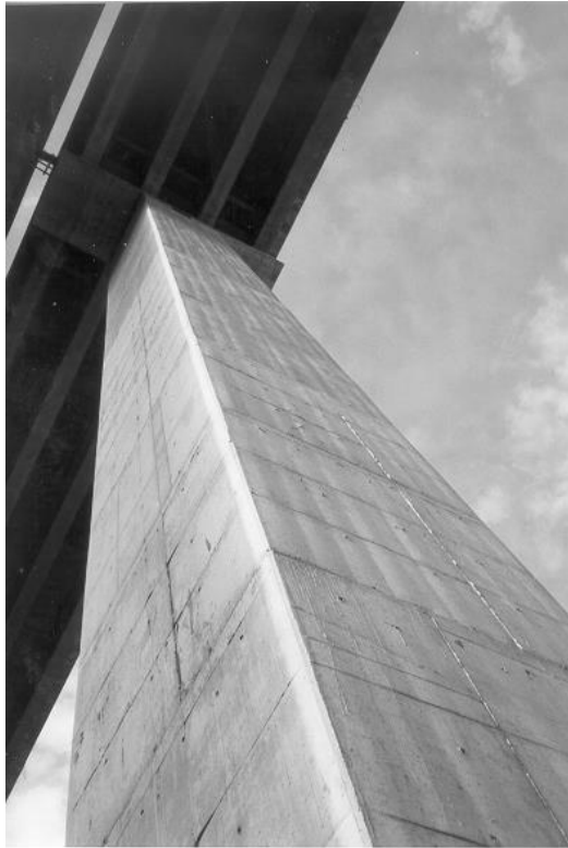
Φωτογραφία Δ.3 Κεντρικό βάθρο της 2 ης χαραδρογέφυρας Καβάλας.
