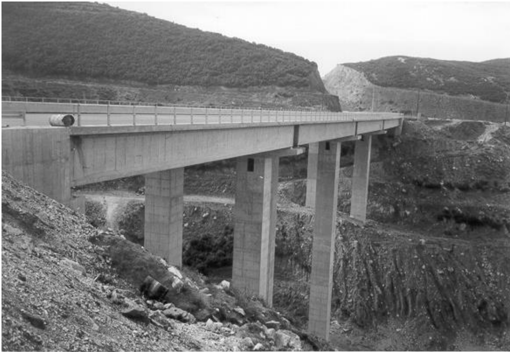
Φωτογραφία Δ.1 Γενική άποψη της 2 ης χαραδρογέφυρας Καβάλας.
