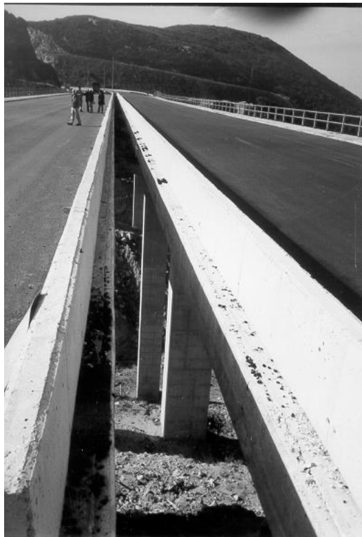
Φωτογραφία Δ.4 Το ενδιάμεσο κενό των δύο κλάδων της 2 ης χαραδρογέφυρας Καβάλας.
