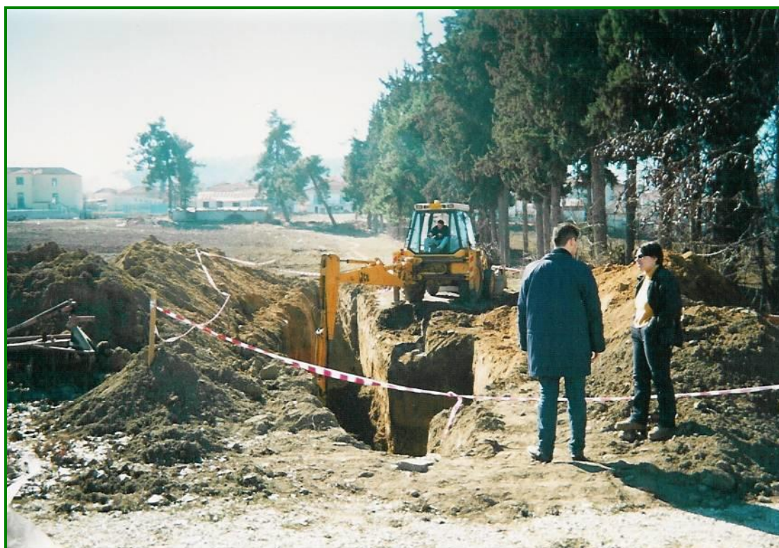
Εικόνα 2-15. Φάση εκσκαφής της παλαιοσεισμολογικής τομής GER-4.
