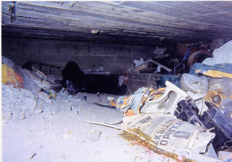
Φωτ. 13: Πιλοτή κτιρίου που υπέστη ολική κατάρρευση. Παρά την έλλειψη τοίχων πληρώσεως υπάρχουν χώροι επαρκείς όχι μόνο για επιβίωση αλλά και για διεξαγωγή κατακόρυφης διείσδυσης ανόδου. (Άσκηση σε ερείπιο, Καλαμάτα 1986)
