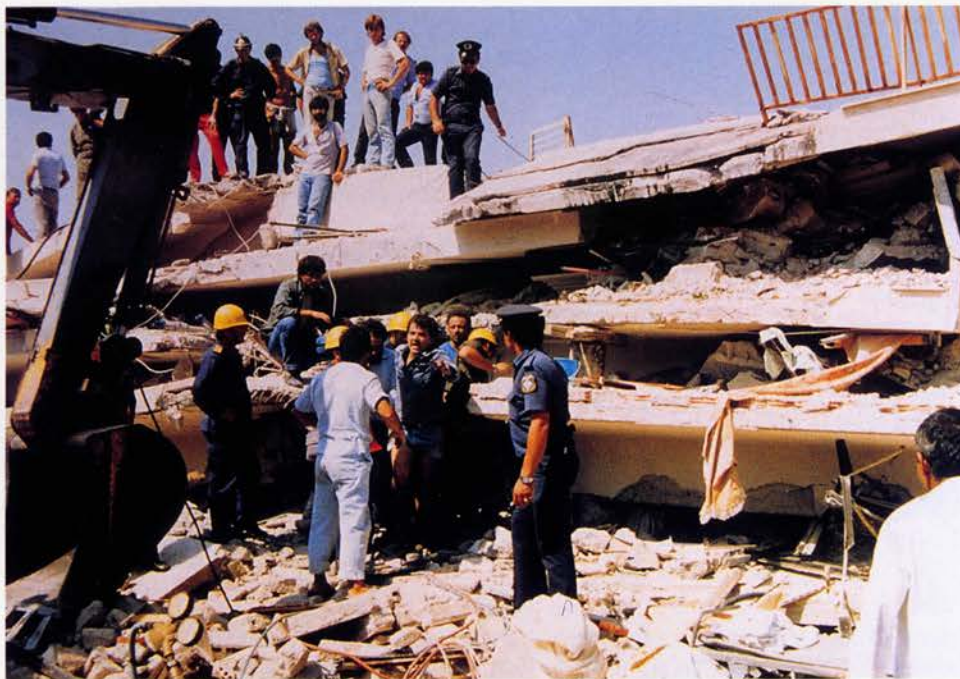
Φωτ. 5-6: Η πρώτη φάση της επιχείρησης σε εξέλιξη, δηλ. δημιουργία διόδου με τεμαχισμό του σκιροδεμένου τμήματος δοκού και πλάκας στο δάπεδο του προς έρευνα ορόφου. Επικοινωνία με παγιδευμένο άτομο σε απόσταση 3-4m από την πρόσοψη. Στην δεύτερη φάση της επιχείρησης, διεξαγωγή οριζόντιας διείσδυσης με τεμαχισμό και απομάκρυνση επίπλων και πλινθοδομών μέχρι την προσέγγιση και διάσωση του ατόμου. Χρόνος διεξαγωγής της επιχείρησης 3-3.5 ώρες. (Επιχείρηση Διάσωσης, Καλαμάτα 1986)
