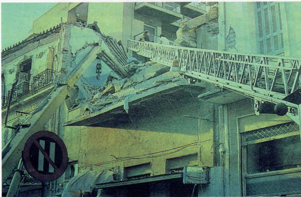
Φωτ. 16: Διάσωση παγιδευμένων από τριόροφο κτίριο στο οποίο κατέρρευσαν μόνο οι δύο ανώτεροι όροφοι. Προφανής ο κίνδυνος για τους παγιδευμένους και τους διασώστες από πιθανή κατάρρευση και του ισογείου σε ισχυρό μετασεισμό. Ο βραχίονας του γερανού αριστερά αποσκοπεί στην παρεμπόδιση της πτώσης του τοίχου του ημιερειπωμένου γειτονικού κτιρίου προς το μέρος των διασωστών. Διασώθηκαν δύο νεαρά άτομα με ελαφρά τραύματα επειδή είχαν την ετοιμότητα να καλυφθούν κάτω από έπιπλα. (Επιχείρηση Διάσωσης, Καλαμάτα 1986)
