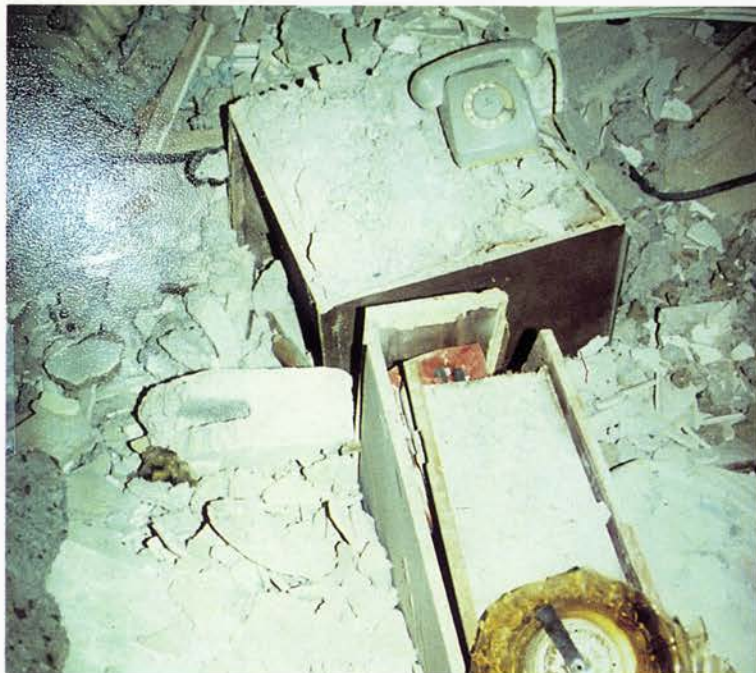
Φωτο 3: Επίπλωση υπνοδωματίου όπως αποκαλύφθηκε μετά την άρση της πλάκας οροφής. Το κομοδίνο και το προσκέφαλο του κρεβατιού έχουν υποστεί βλάβες από την πτώση τούβλων και επιχρισμάτων, έχουν όμως διατηρήσει το αρχικό τους ύψος. Αυτονόητη η χρησιμότητα της οδηγίας για κάλυψη σε πρηνή θέση κάτω από γερό έπιπλο.
