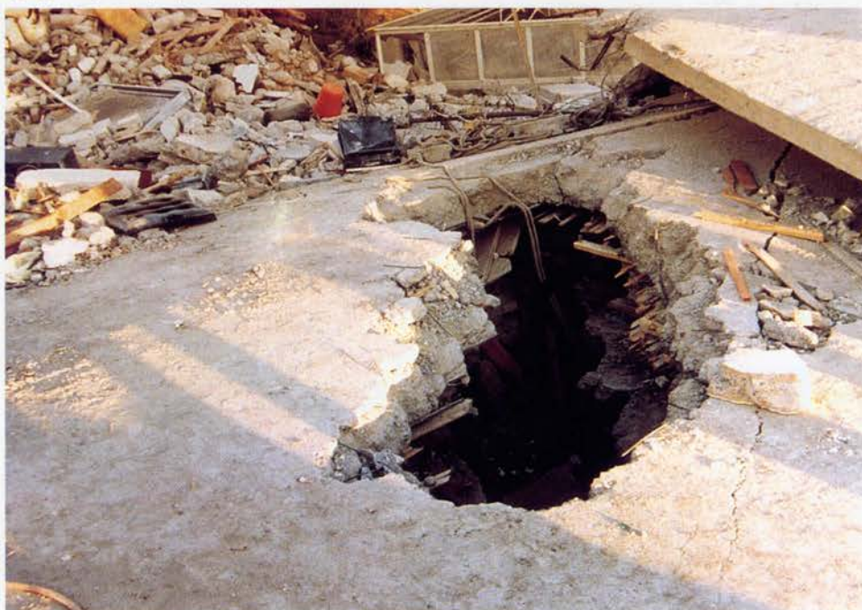
Φωτ. 12 : Άνοιγμα κατακόρυφης διείσδυσης καθόδου σε θέση που η πλάκα εμφανίζει μικρή κλίση προς το οριζόντιο επίπεδο αντίθετα με ότι συμβαίνει λίγο αριστερά. Διατρήθηκαν δύο πλάκες και ακολούθησε οριζόντια διείσδυση με κλίση προς τα κάτω μέχρι το σημείο που υποδεικνύεται με το βέλος. Διασώθηκε βρέφος 24 ώρες μετά το σεισμό. (Διασωστική Επιχείρηση, Καλαμάτα 1986)
