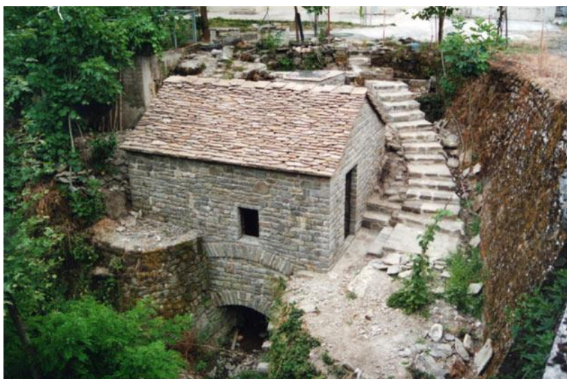
Γενική άποψη του μνημείου
