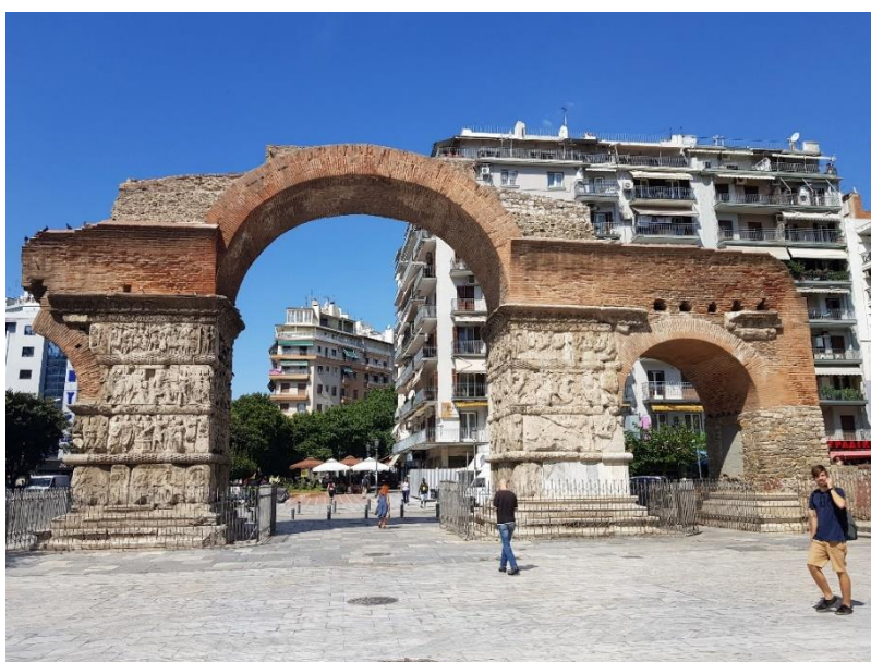
Γενική άποψη του μνημείου
