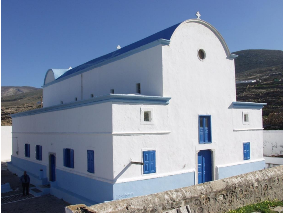
Γενική άποψη ναού (Βορειοδυτική όψη)
