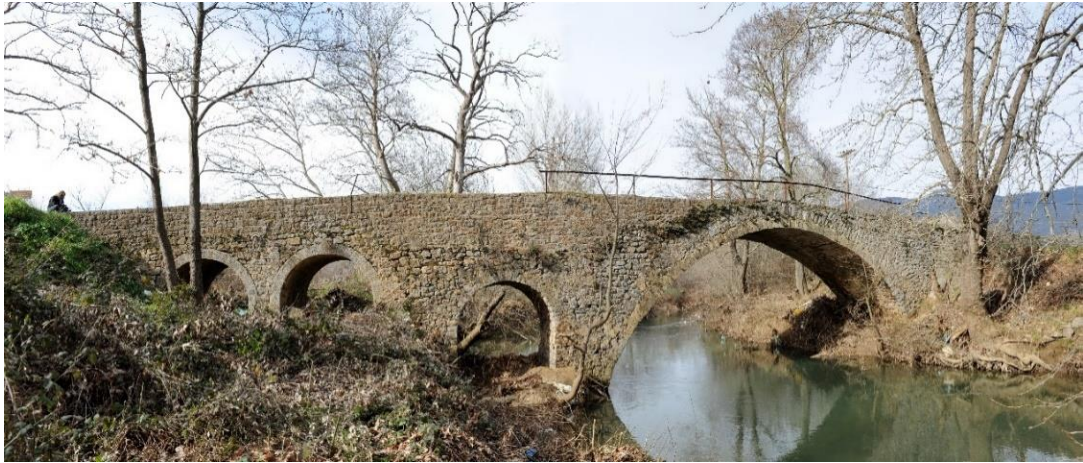
Γενική άποψη της γέφυρας
