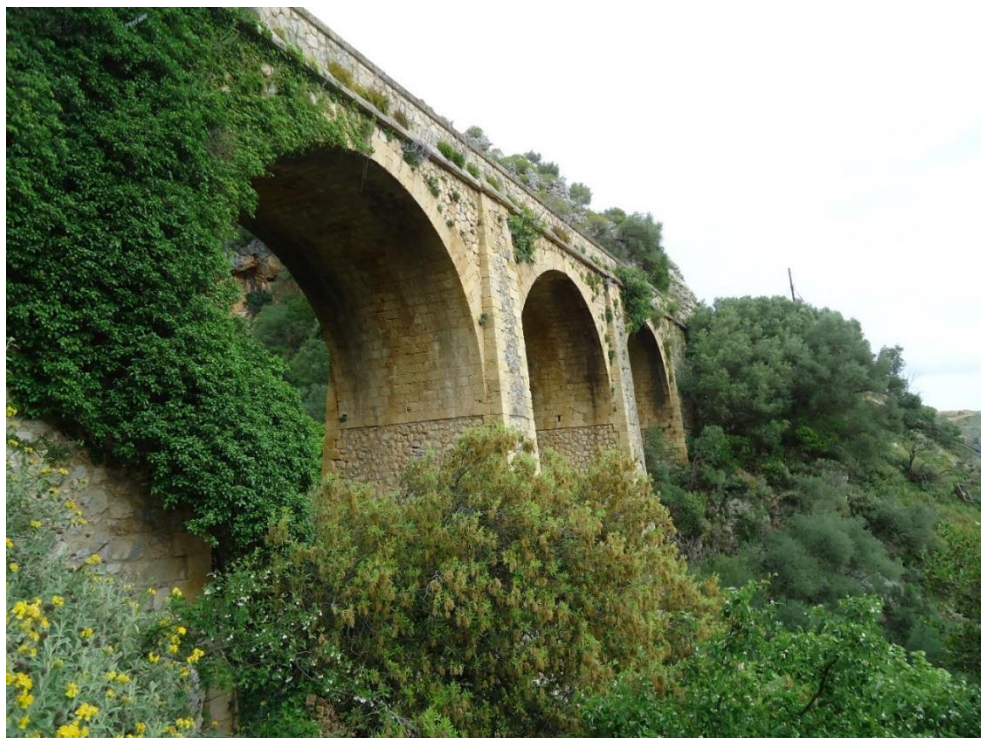
Νοτιοανατολική όψη γέφυρας
