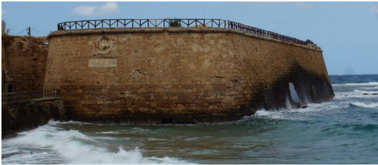
Νότια όψη τειχών
