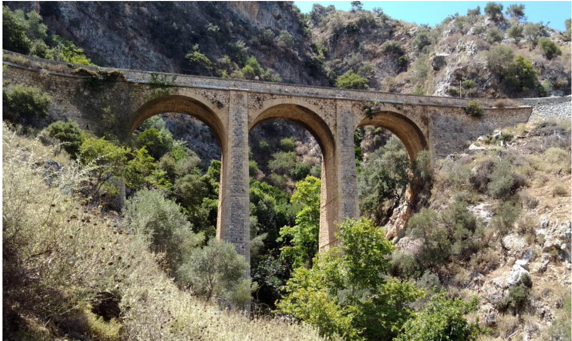
Γενική άποψη της γέφυρας (Ανατολική όψη)
