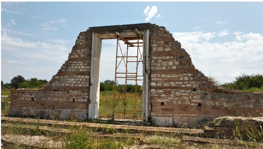
Γενική άποψη του μνημείου
