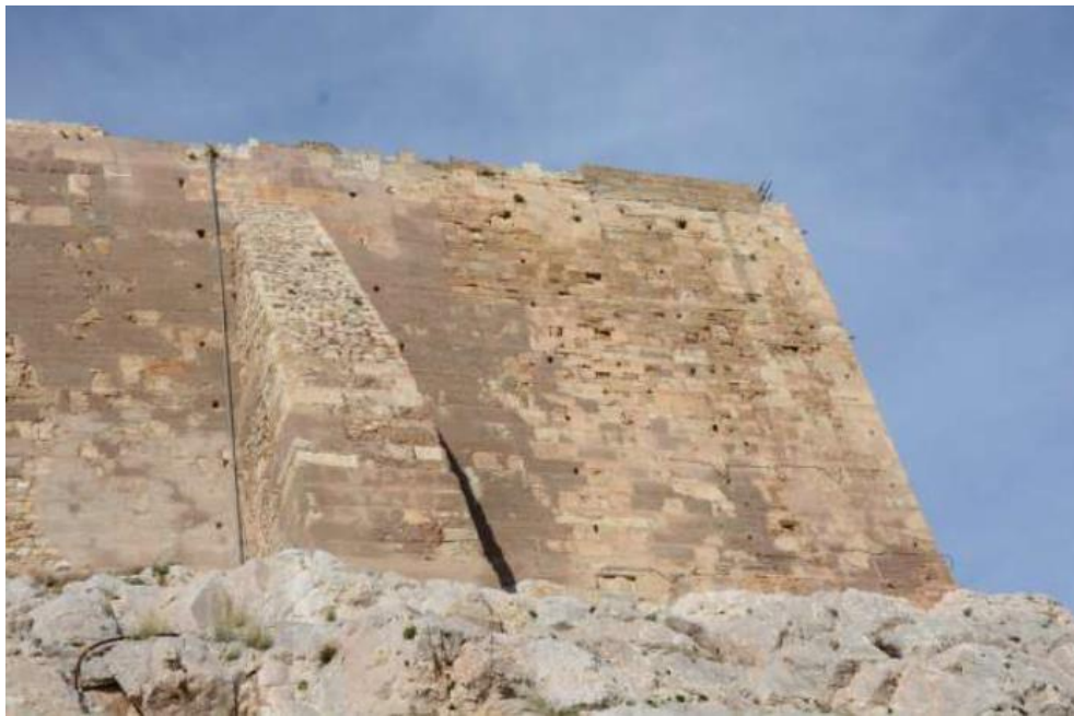
Νοτιοανατολική Γωνία Τείχους
