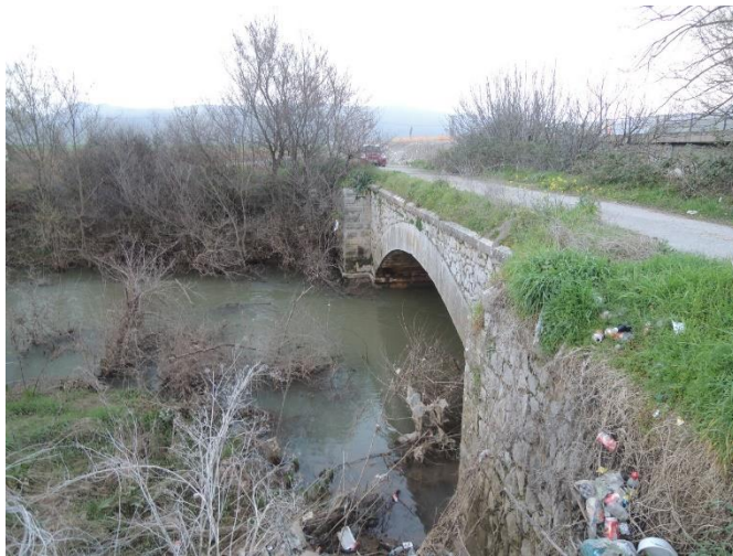
Γενική άποψη της γέφυρας
