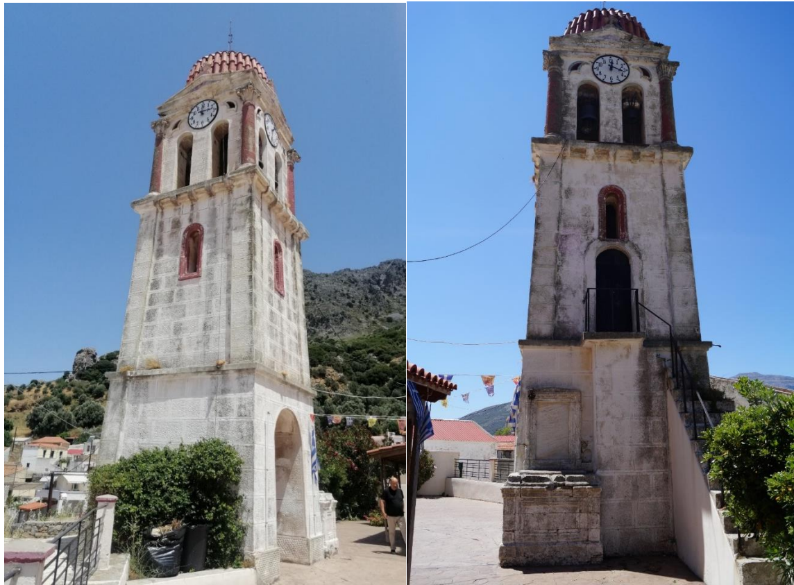
Γενική άποψη καμπαναριού (Νοτιοανατολική και βόρεια όψη)
