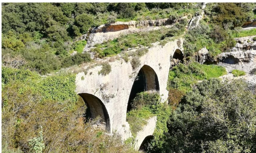
Γενική άποψη υδατογέφυρας (Νότια όψη)
