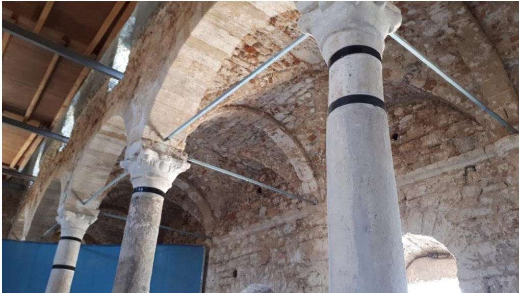
Όψη κιονοστοιχίας - σταυροθολίων
