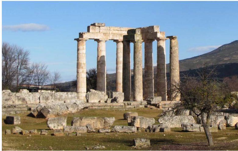
Γενική άποψη του μνημείου
